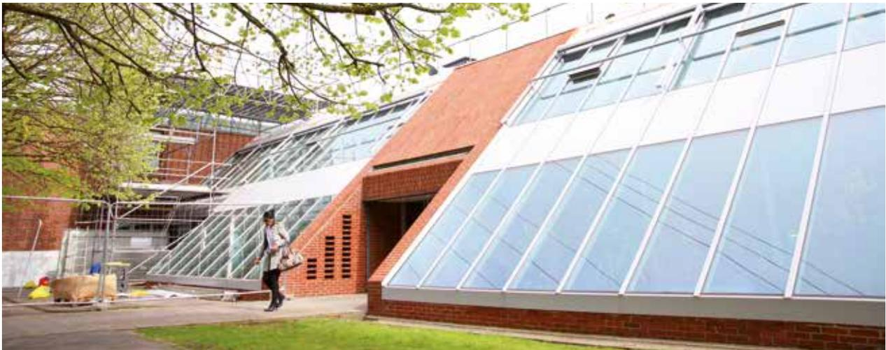
Nouvelle enveloppe de verre, ventilation par cheminée solaire, bureaux privilégiant l'éclairage naturel... Le siège de Rabot Dutilleul Construction à Wasquehal (59) s'est offert un lifting énergétique.
